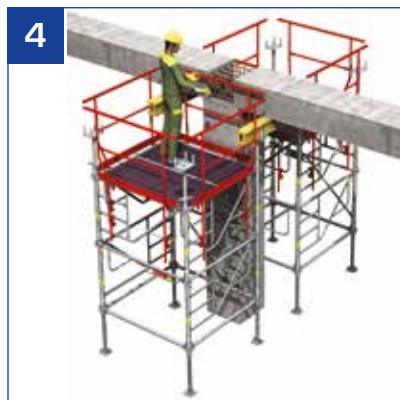
4 - Einsetzen der Betonträger: Sicherheitsgeländer in oberer Stellung.
