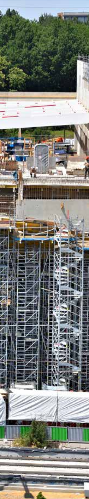
Baustelle: Staatsbibliothek in Luxemburg Kunde: Tralux Ort: Kirchberg
