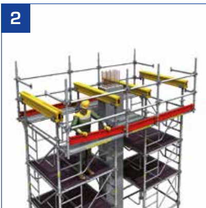
- Einsetzen der Konsolen, Stiele, Riegel, 0,30 m-Beläge und Bordbretter.
